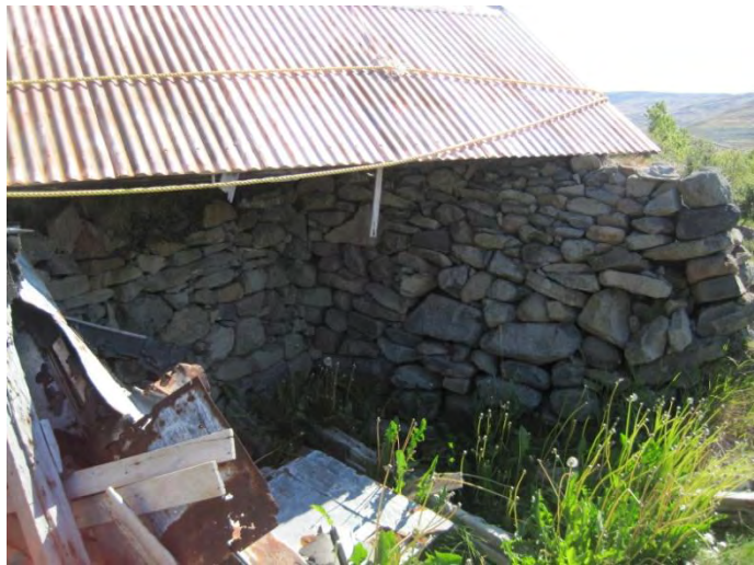
Mynd 4. Þrír af veggjum byggingarinnar standa enn og þak er fest við húsið.
