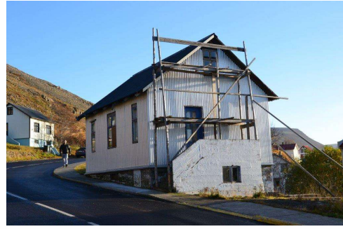
Dallahús 2017, unnið að uppgerð.
