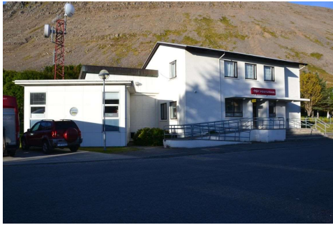
Pósthúsið með viðbyggingu Battránsins.
