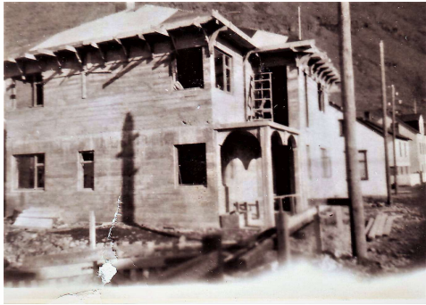
Húsið í byggingu 1944
